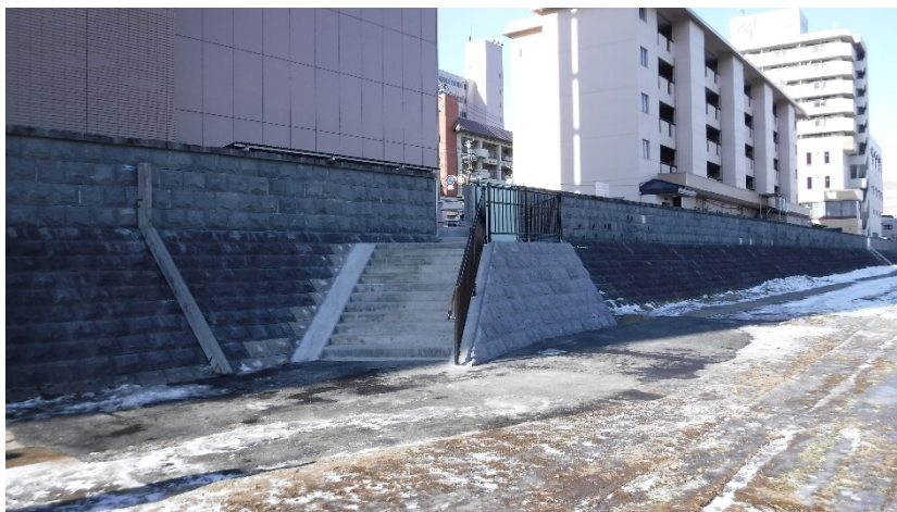
写真 3-3 工事完成後 (H31. 1. 21 時点)
