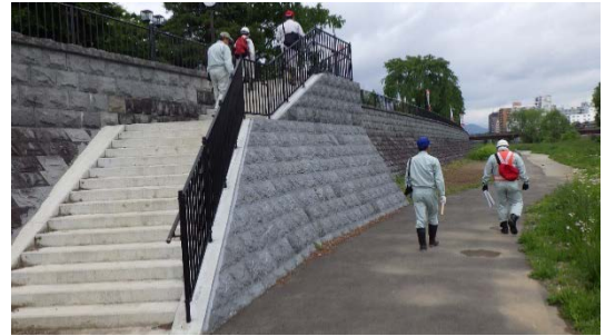
写真 3-2 木伏緑地階段事例
