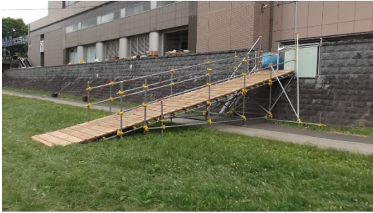
写真 3-1 例大祭時設置の仮設階段 (H30. 6)
